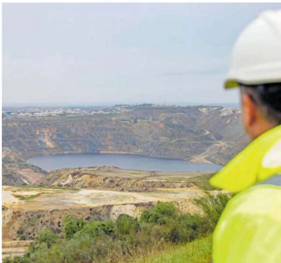
Corta de Los Frailes, en la mina de Aznalcóllar, en diciembre de 2024. PACO PUENTES
